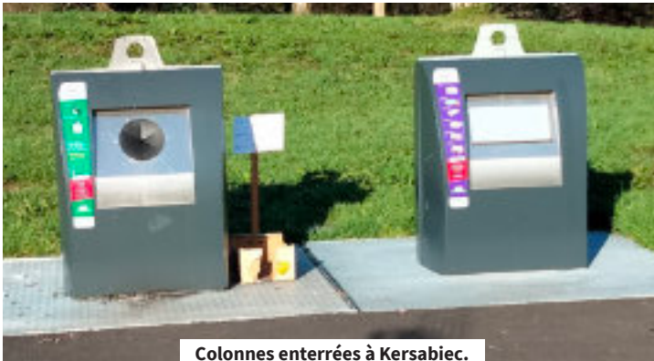
Colonnes enterrées à Kersabiec.
